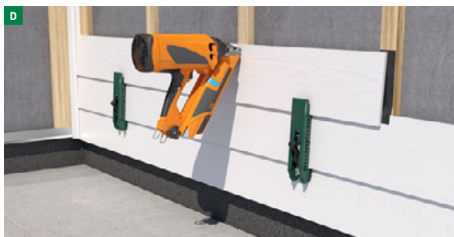
D : Clouer au pistolet ou visser (préforage superflu).
