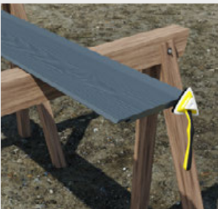
Application de l'enduit de traitement de chants ColourPlus™.
